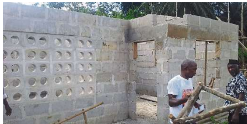
Nach der Regenzeit: Der Schul(roh)bau ist im Werden.
